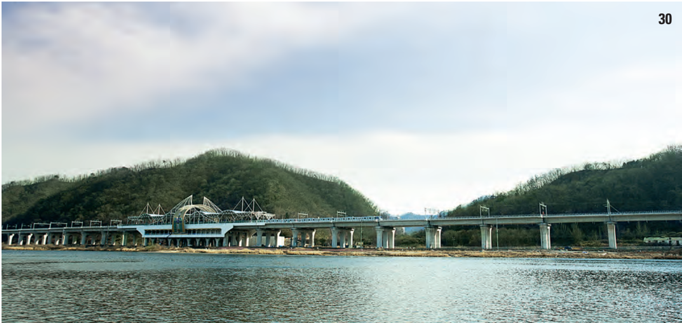
29. 현풍~김천간 고속도로 위치: 경상북도 김천시 - 총연장 28.8km, 왕복 4차선 - 교량 32개소(6.05km) - 터널 4개소(7.7km) 공사기간: 2001. 12 ~ 2007. 12 30. 경춘선복선전철 제7공구 위치: 강원도 춘천시 - 총연장 12.15km - 교량 5개소 / 3.22km - 터널 4개소 / 8.19m, 정거장 2개소 공사기간: 1999. 12 ~ 2011. 12
